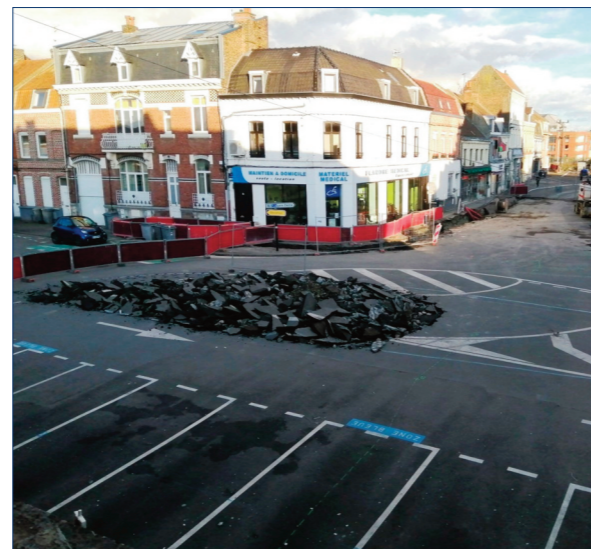
Le 6 mars 2020, du haut de la salle municipale Barbusse, l'ancienne place Saint-Piat se prépare au lifting.
