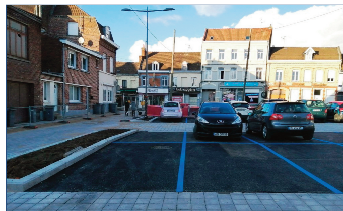
Un nouveau parking de 25 places a été créé tout début 2020 à l'angle des rues Séward et Péri. Il est en zone bleue.
