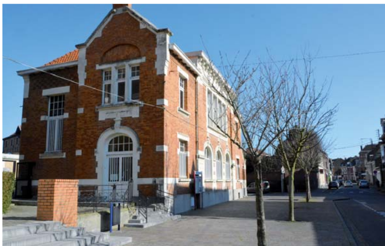
L'ancienne Trésorerie, rue Jean-Jaurès, sera réaménagée pour accueillir la Police Municipale et le Service Culture de la Ville.
