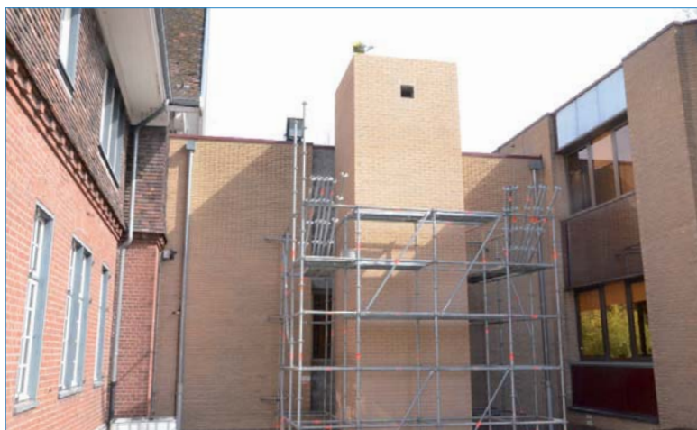
Un ascenseur est en cours de construction à l'Hôtel de Ville pour améliorer l'accessibilité du bâtiment communal aux personnes à mobilité réduite.
