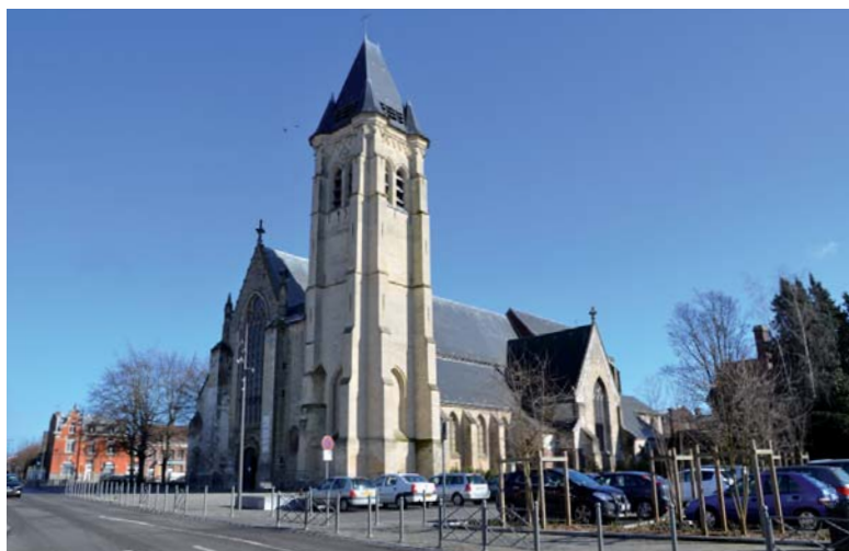
Côté investissements, la Ville prévoit d'engager la 2 ème phase des travaux à la collégiale.
