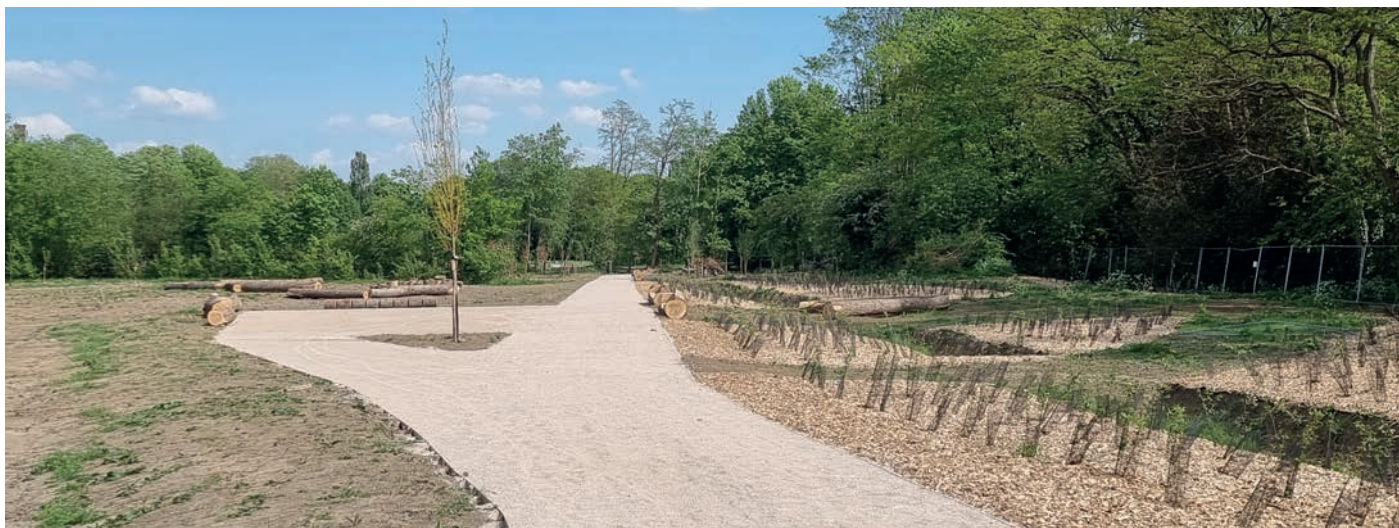
La première section de la voie verte des captages prend forme.
